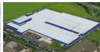
Hörmann KG Ichttershausen, Allemagne
