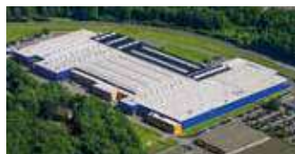
Hörmann KG Eckelhausen, Allemagne
